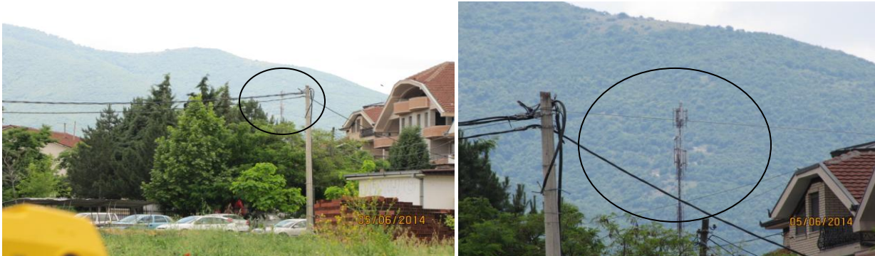
Сл.2 Поглед кон базната станица на мобилниот оператор
